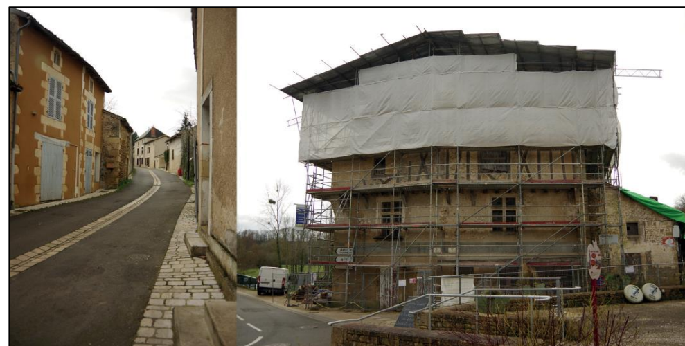
Ruelles étroites et maison ancienne dans le centre bourg de Jazeneuil Source : Résonance Urbanisme et Paysage 2020
